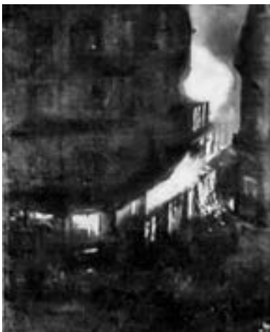
“Chispas y trozos incandescentes saliendo por las vidrieras y amenazando los edificios de la acera oeste de la calle Perú.”
